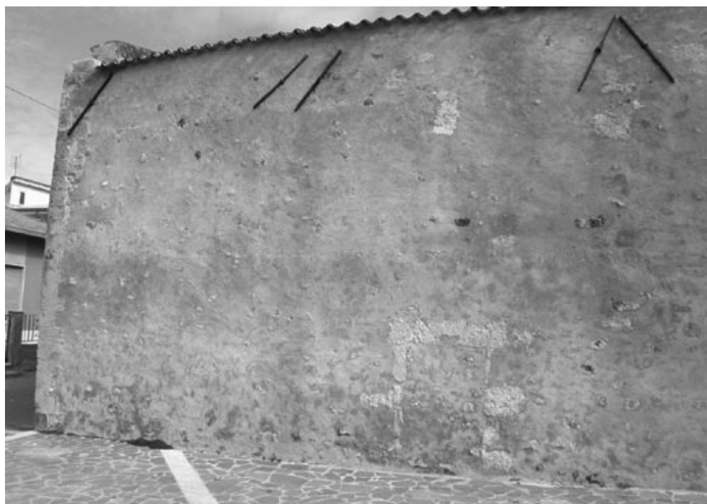
Fig. 6 – Il prospetto esterno del perimetrale Sud: si nota la porta laterale tamponata (foto M. Milanese).
