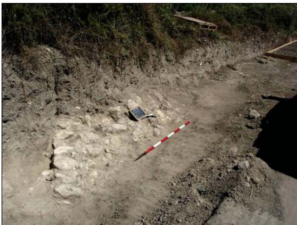
Un'immagine dell'US 20: a sin. Si nota il paramento Nord della struttura e l'US 22 subito dopo il rinvenimento.
