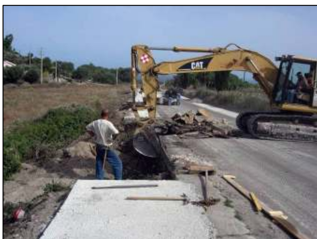
Sotto e nella pagina seguente: alcuni momenti della demolizione.
